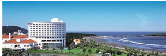
図2 青島リゾートホテルの外観
